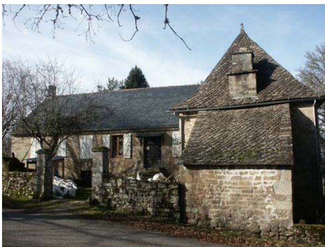
Logis de ferme indépendant avec adjonction d'une tour à Noger.
